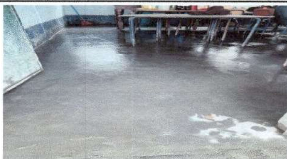
Foto 5: piso liso finalizado
