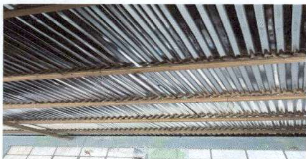
Foto 1: Finalizacion de cubierta de lamina
