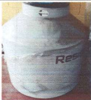
Foto1: Depósito de agua instalado
