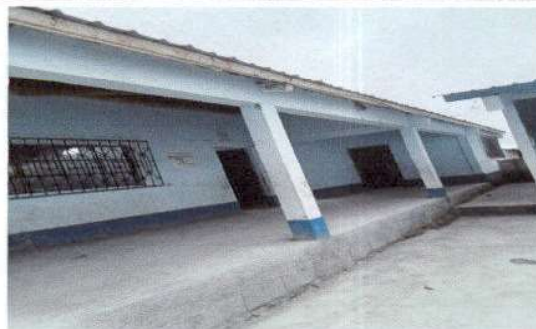
Foto 4: Torta de cemento finalizada
